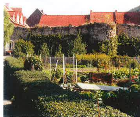
Die Gebäude mit ihren homogen gestaffelten Firstlinien treten bewußt hinter der historischen Stadtmauer zurück.
