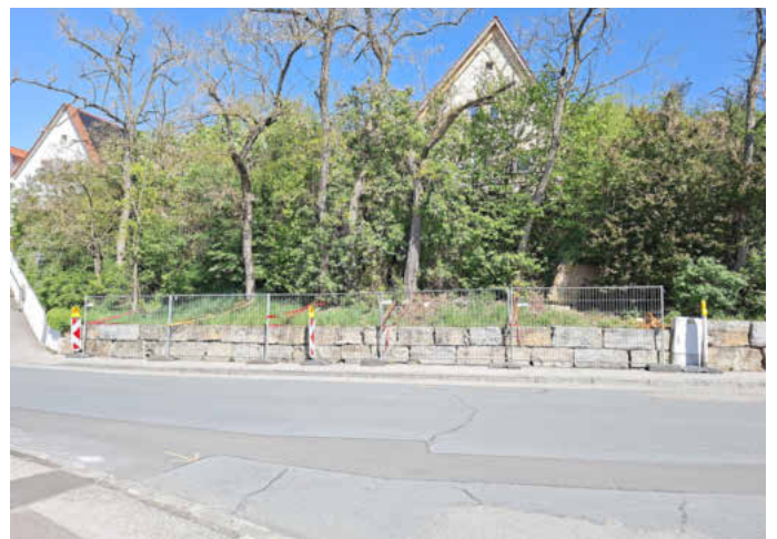
Zum Schutz von Fußgängerinnen und Fußgängern sowie des Straßenverkehrs wurde im betroffenen Bereich vorsorglich ein Bauzaun aufgestellt.
